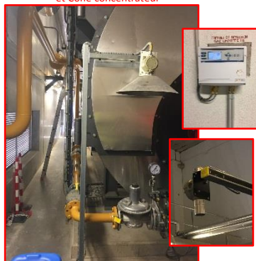
Détection gaz avec capteurs ATEX et Cône concentrateur
